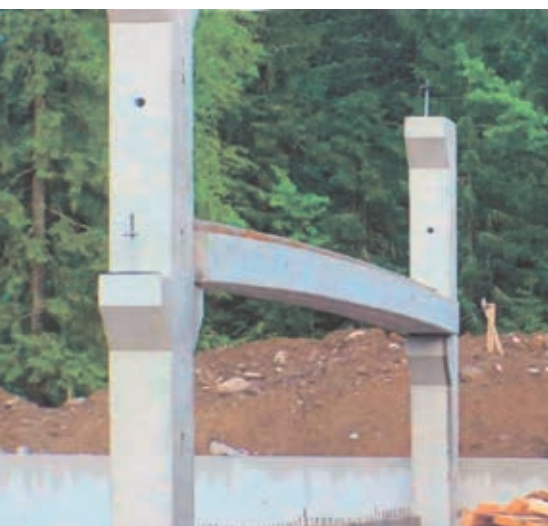
Фото 5. Узел сопряжения мачтовых колонн и большепролетной предварительно напряженной балки.
